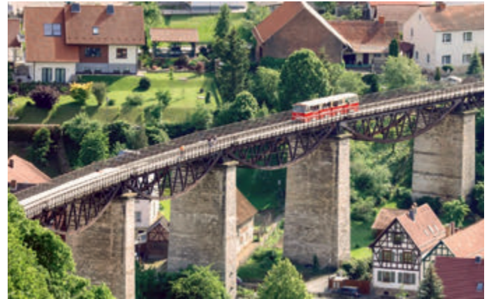
Viadukt mit Elektro-Draisine
